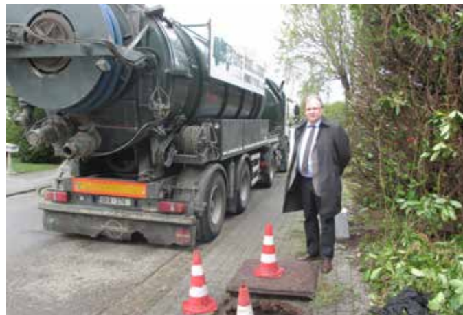
▲ Chris Backx aan de onderhoudswerken in de Baron Empainlaan (Battel).
